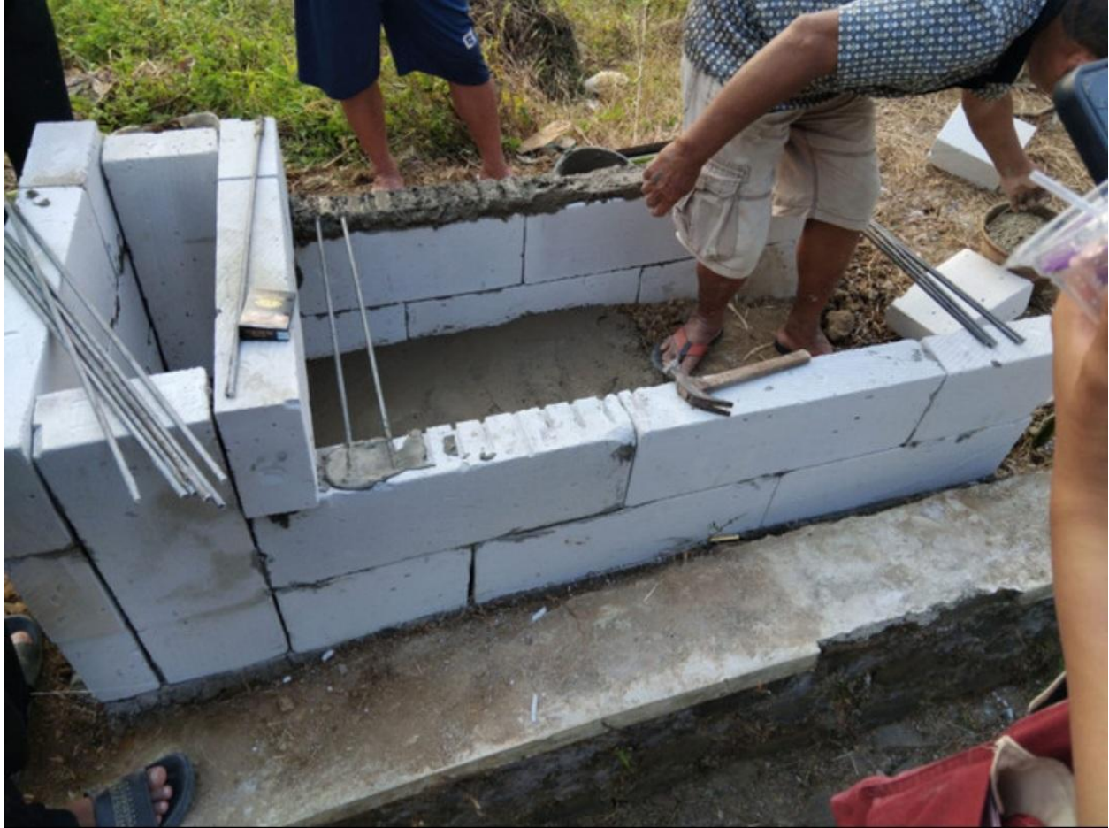
Pembuatan Rocket Stove di Dusun Nganceng
