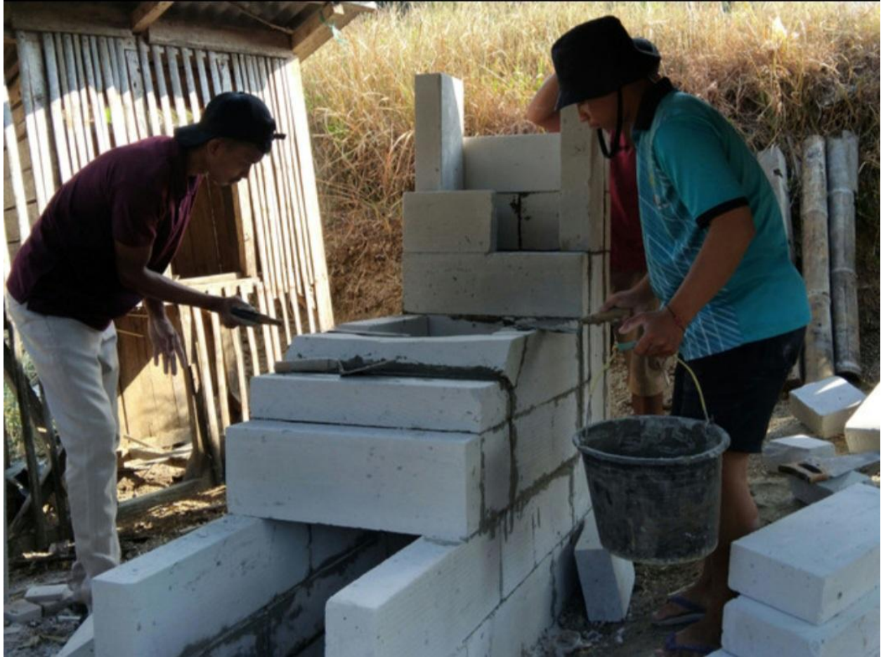
Pembuatan Rocket Stove di Dusun Cinangsih
